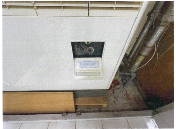
東元箱型冷氣(已故障), 本處不再辦理修繕, 現況點交, 原況返還。
