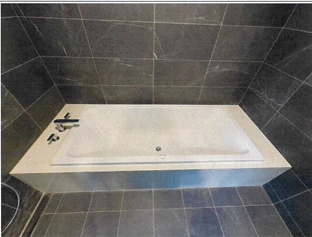
主臥浴室浴缸
