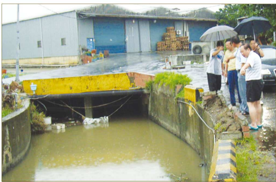
林會長率同仁巡視社子地區圳道受損情形
