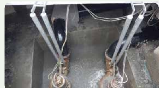
▲ 社子三區抽水站集水井改善工程完工後照片
