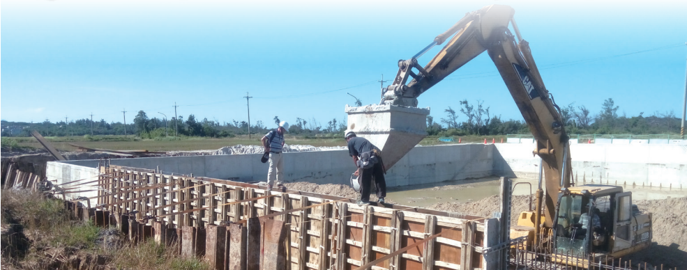
▲ 本工程護岸混凝土澆置作業
