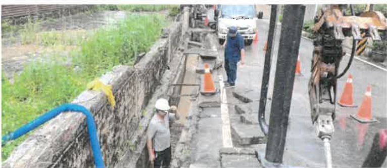
▲廣興圳圳路維護工程施工狀況
