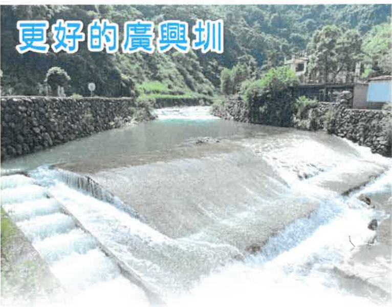
▲廣興圳攔河堰及進水口維護工程施工前後比對
