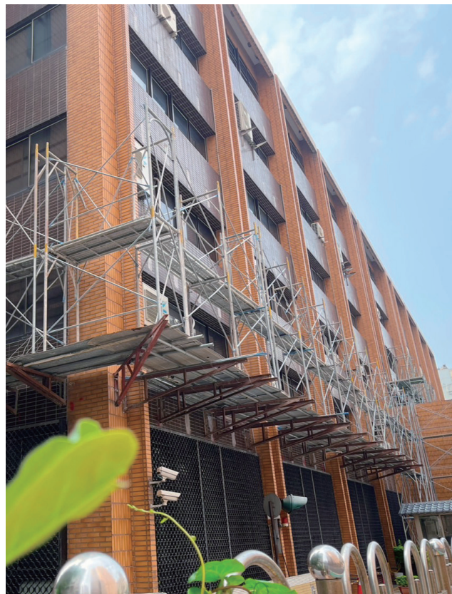
▲瑠公復興大樓辦公廳舍結構補強工程正在進行中
