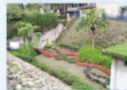
▲保留卵石壙砌的堤壁具多孔隙生態植栽意義
