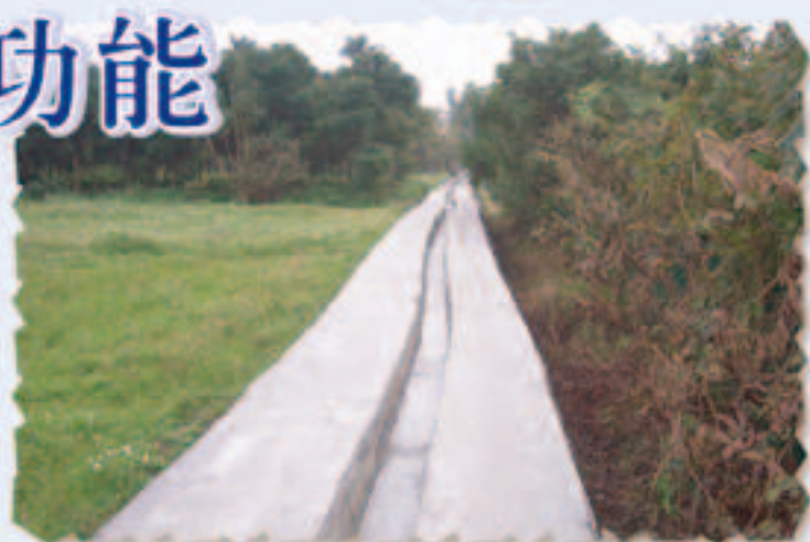
▲完工後之「大坪林圳西幹線第7小給水路內面工改善工程」
