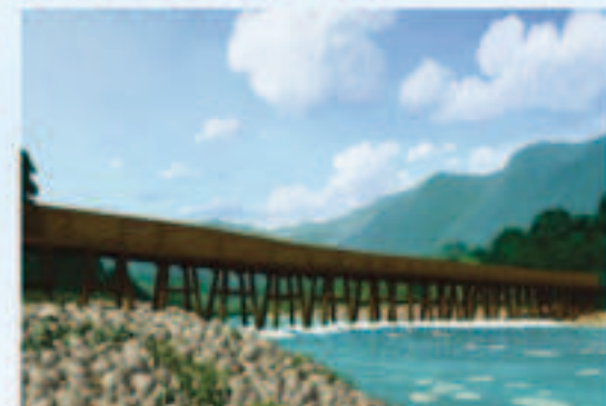
▲木規，又名渡槽，用木板製成的U型木槽用來輸送水源
