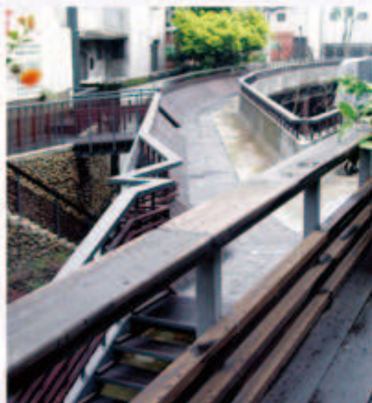
▲首段工程竣工後所呈現圳道上行行人觀景曲橋迷人風情。
