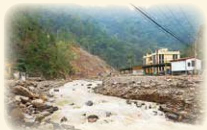
▲廣興圳灌區受損之情形。
