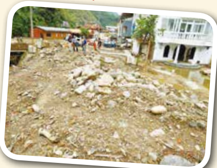
▲蘇迪勒颱風肆虐，新店灌區廣興圳攔河堰及渠道受創嚴重，本會工作人員現場勘災。
