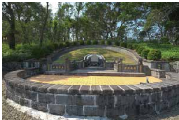
▲整修瑠公墓塚，改善老舊及裂痕等問題
