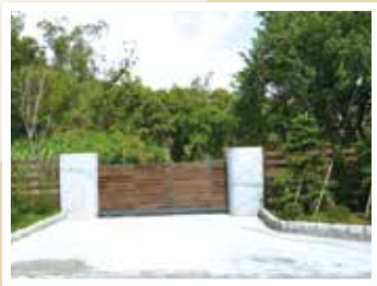
▲原有簡易鐵門改建為手推式雙軌大門並改善門口景觀以強化入口意象
