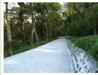
▲改善斜坡道鋪面
