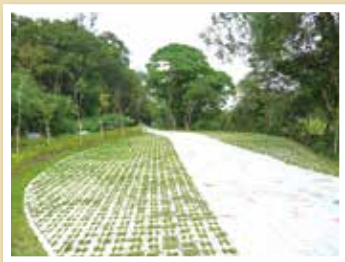
▶入口處道路及公共迴車區採用透水磚鋪面修繕，兩側腹地鋪以植草磚，並將周邊景觀綠美化
