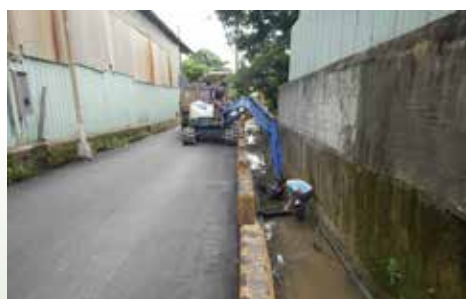
▲社子排水 1 區 3 支線進行清淤工作
