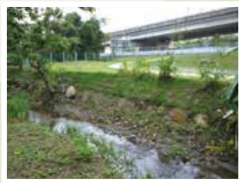
▲溪溝岸邊進行石塊疊置、砂石袋填充及鋪設草毯加強護坡工作
