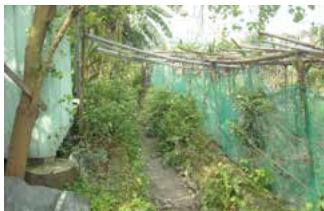
▲新店大坪林圳排水渠道周邊雜草叢生，影響通行
