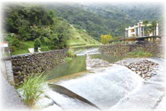
▲完工後之廣興圳進水口攔河堰順利取水
