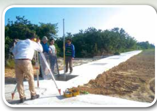
▲農塘整治工程驗收量測排水溝深度及尺寸
